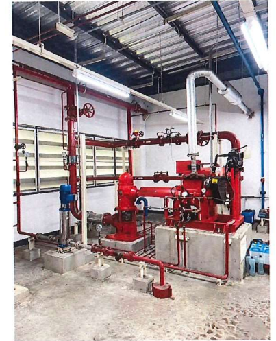
ระบบเครื่องสูบน้ำดับเพลิง
